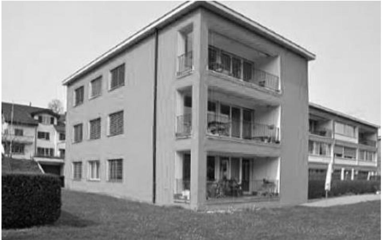
Im Sommer 2019 soll eine Teilsanierung der beiden Mehrfamilienhäuser Demutstrasse 21 und 23 realisiert werden. Dabei wird die Fassadendämmung mit Verputz instandgesetzt.
